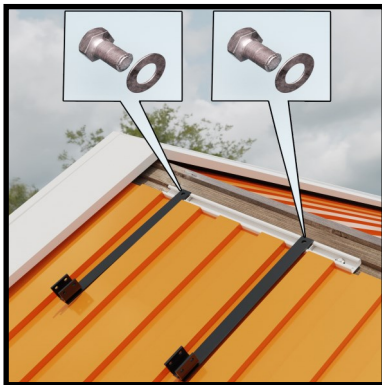
5. Fest fast øvre festestag 2 . Bruk bolt 6 , skive 11 og mutter 9 .
